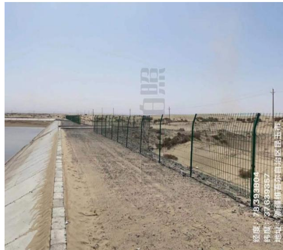
沉沙蓄水池围挡
