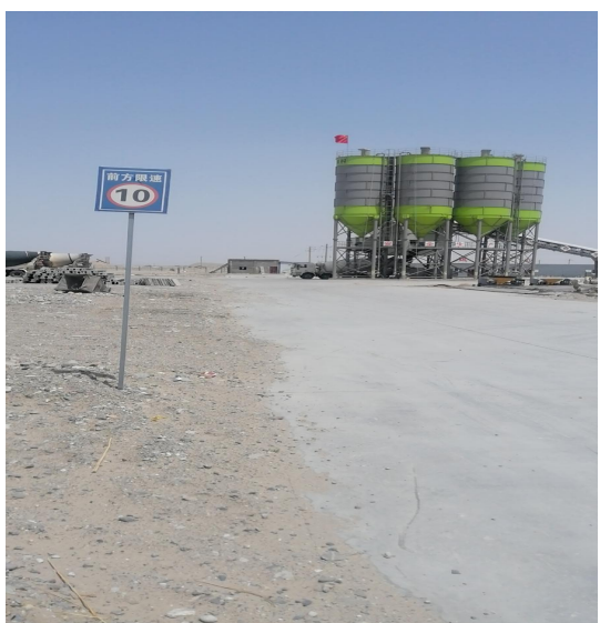
废气防治措施
