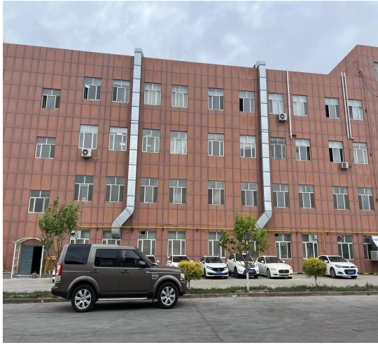
废气处理设施
