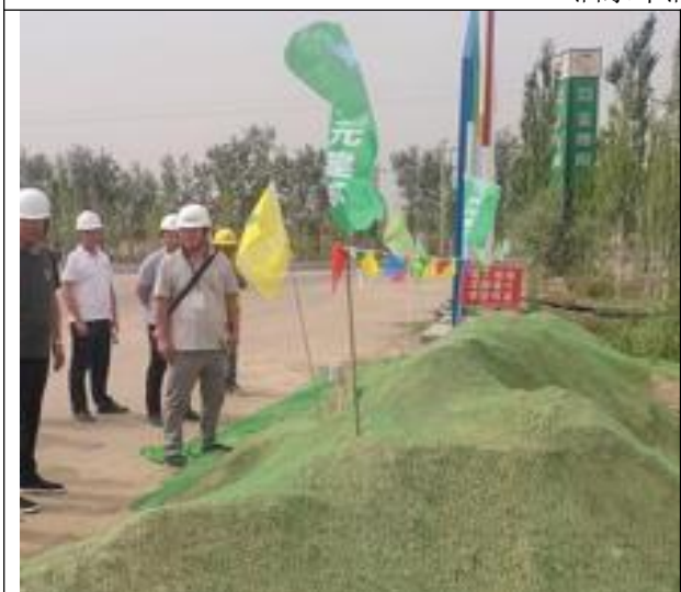
临时堆土防尘网苫盖
