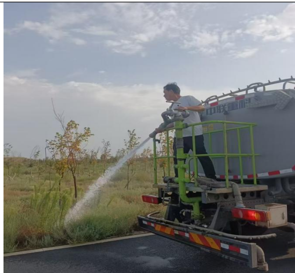
临时道路洒水
